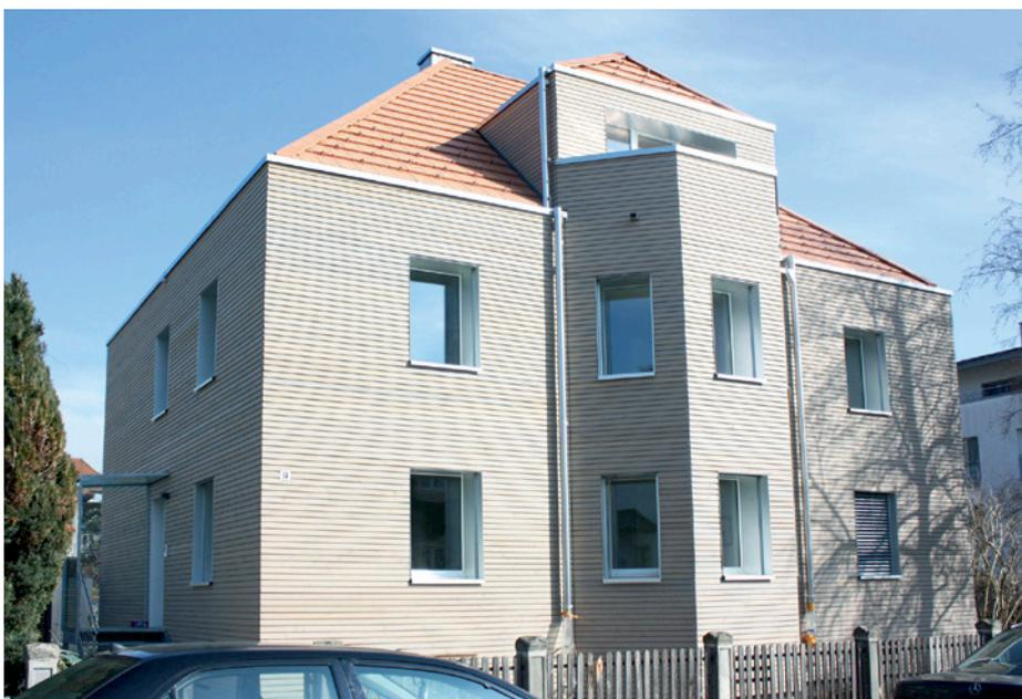
Lichtschutz- und Feuchteschutzimprägnierung sind in der Praxis bewährte Mittel, um dem verbreiteten Wunsch einer langsamen und gleichmässigen Alterung von Holzfassaden zu entsprechen. Dies gilt auch für die im Trend liegenden vorvergrauten Fassadenschalungen.
