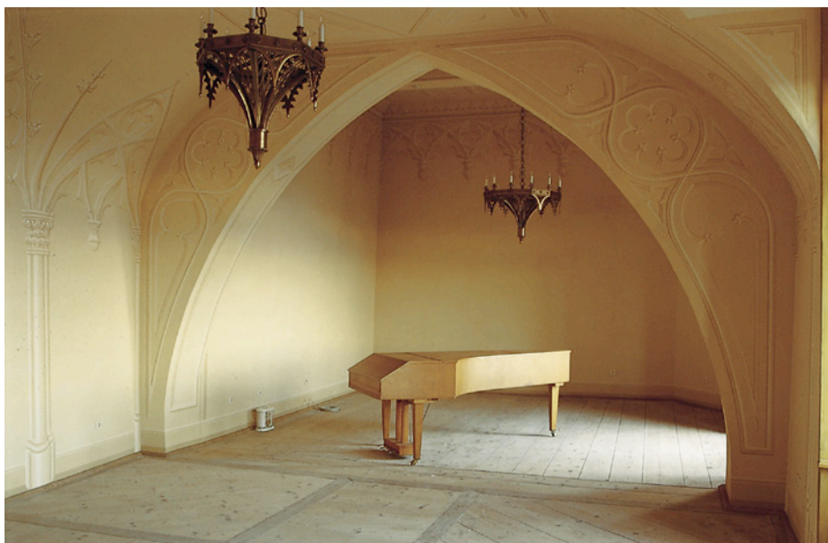
Diffusionsoffene und kapillaraktive Silikatfarben auf sorptionsfähigen Wänden unterstützen ein ausgeglichenes Raumklima, wie es empfindliche Musikinstrumente benötigen. Vor allem im Denkmalsbereich werden Produkte ohne Kunststoffdispersion besonders geschätzt. (Bild: Beeck)
