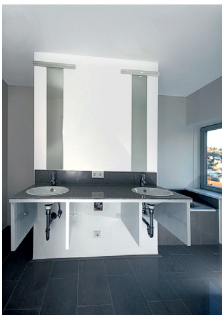
Besonders in Räumen mit temporären Feuchtespitzen wie Bade- und Schlafzimmer reduzieren sorptionsfähige Materialien die Schimmelgefahr. Bei dieser Sanierung ergänzt eine alkalische Kalkfarbe die Raumabluftanlage. (Bild: Manderscheid)
