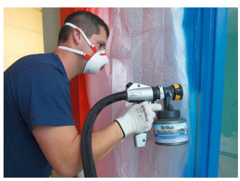
In einem Seniorenwohnheim mit 60 Wohneinheiten waren Türzargen in unterschiedlicher Farbgebung zu beschichten. Für den schnell trocknenden Hydro-PU-XSpray sprach, dass die Lacke im 1-Liter-Gebinde individuell getönt und verarbeitungsfertig waren. Ein Einstellen der Spritzviskosität entfiel. Die Farbwechsel waren leicht zu meistern.
