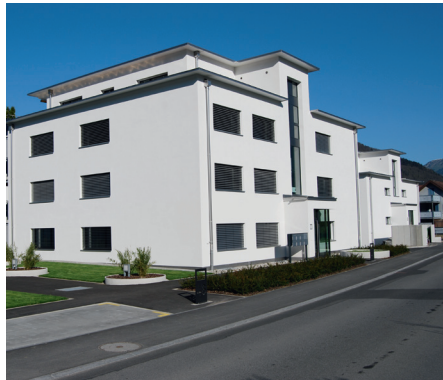
Das Hospiz auf dem Simplonpass (links) und dieses Objekt in Ibach (rechts) wurden mineralisch verputzt.
