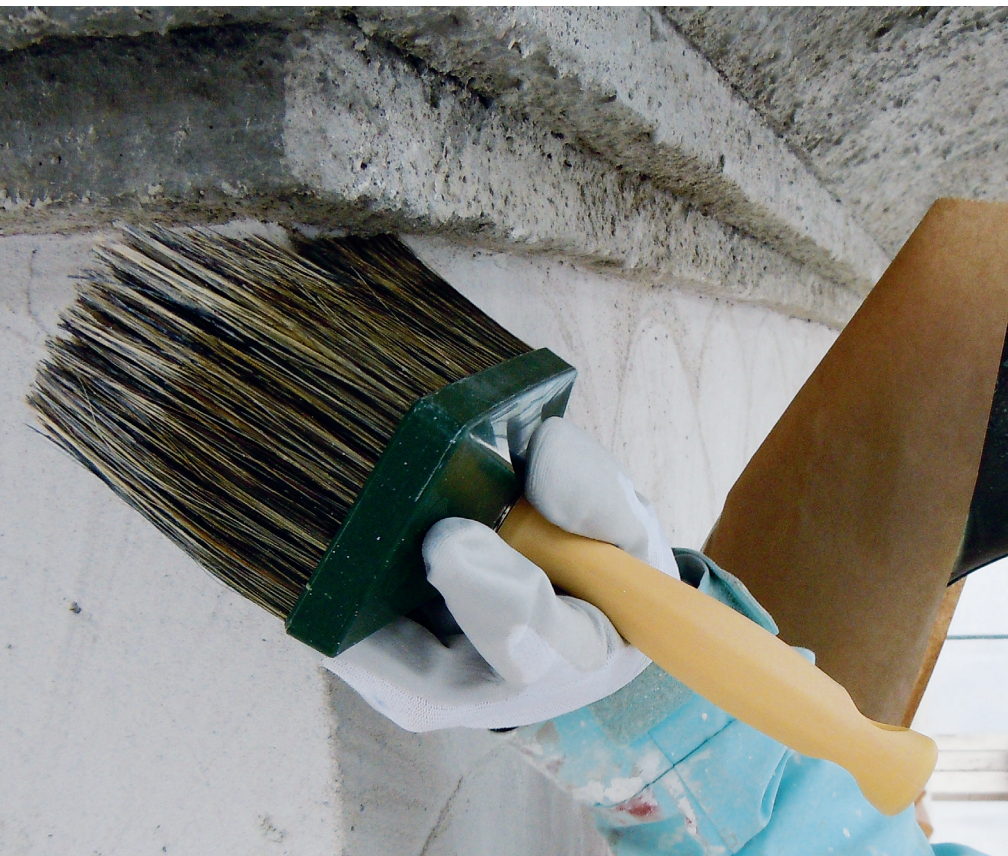
Die Reinsilikatfarbe wird mit einer Bürste aufgetragen.
