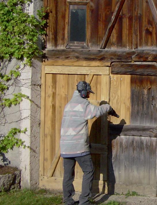
Um verwittertes Holz aufzufrischen, genügt in der Regel ein einmaliges Darüberfahren mit dem Strahl. (Bild: K. Lips AG)
