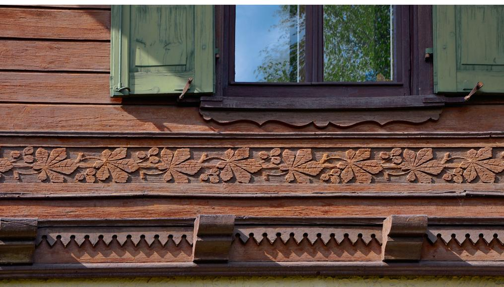
Die Fassadenflächen wurden mit Olivin gestrahlt, die empfindlicheren Schnitzereien mit Glasbruch.
