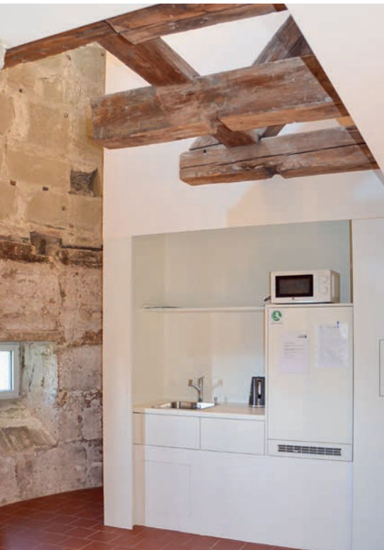
Trockenbaukonstruktion im Bereich der «Schoppenküche». Wichtig ist der Brandschutz. (Bilder auf dieser Doppelseite: Raphael Briner)
